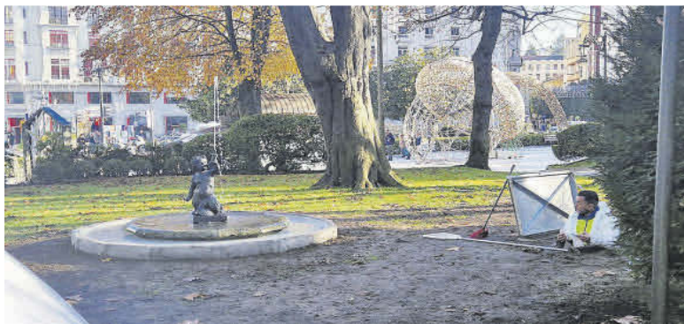
Un técnico, probando ayer la nueva fuente del «falso» Angelín, con el paseo de los Álamos al fondo.
