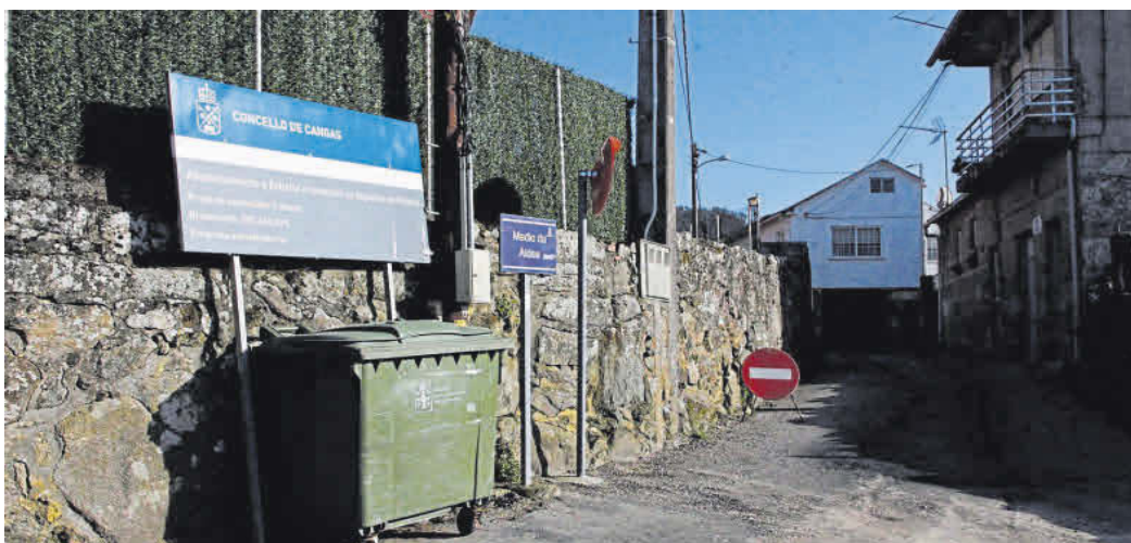
Obras de abastecimiento de Erbello. | G.Núñez
